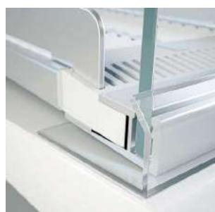
Tope colocado en la balda para evitar que la plancha caiga de la estantería.
